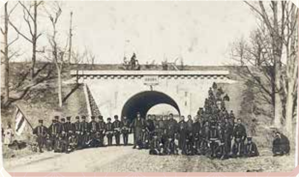
100年前の利根川隧道 旧国道52号 (写真提供:土橋亨様)
