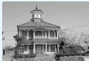
旧菴米学校の改修工事を開始
