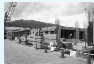
中学校建設、順調に進行中
