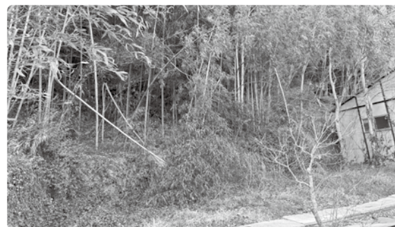
建物にせまる急傾斜地
