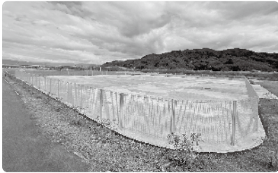
完成間近のスケートボードパーク
