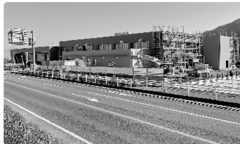
現在は建設中の新庁舎 (令和7年12月撮影)
