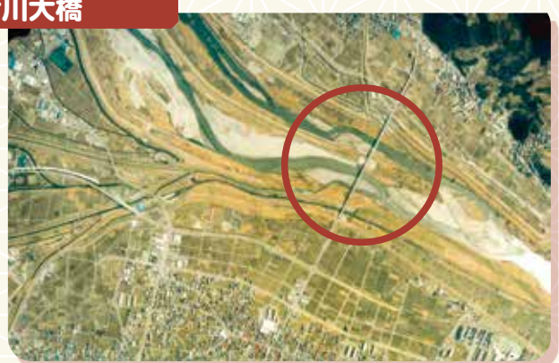
工事完成(富士川町記録資料より)
