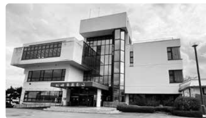
解体される東別館
