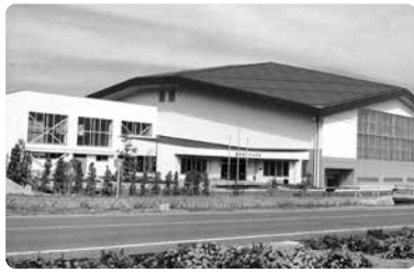
解体された町民体育館
