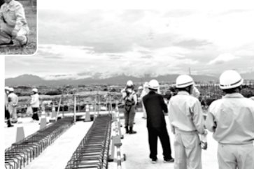
完成間近の高架橋上部
