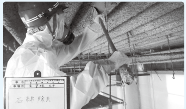
天井裏のアスベスト除去作業
