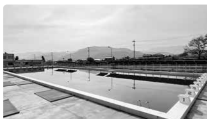
改修塗装工事予定の利根川公園プール
