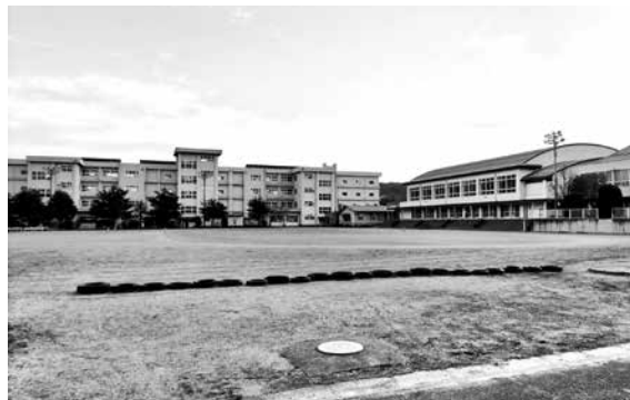
合併推進債を活用した新中学校建設
