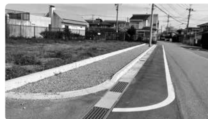
整備が進む町道 最勝寺小林1号線
