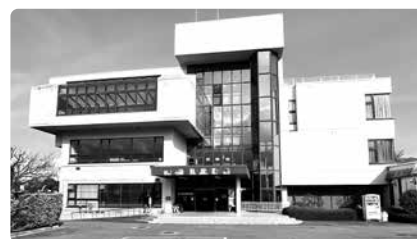
取り壊し予定の東別館
