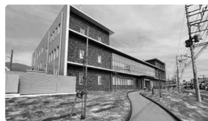
完成した新庁舎外構工事(一期)
