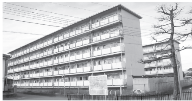
改修が済んだ町有青柳町団地
