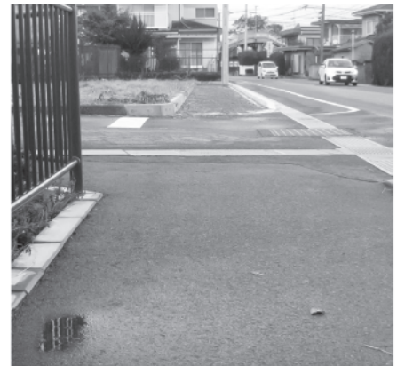
歩道整備が進む最勝寺小林1号線
