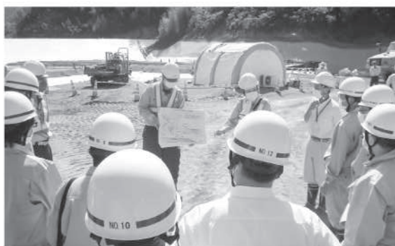
保守基地変電所工事現場（高下地内）
