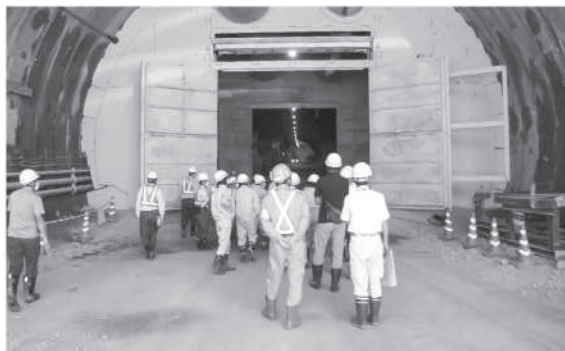
トンネル工事現場を視察
