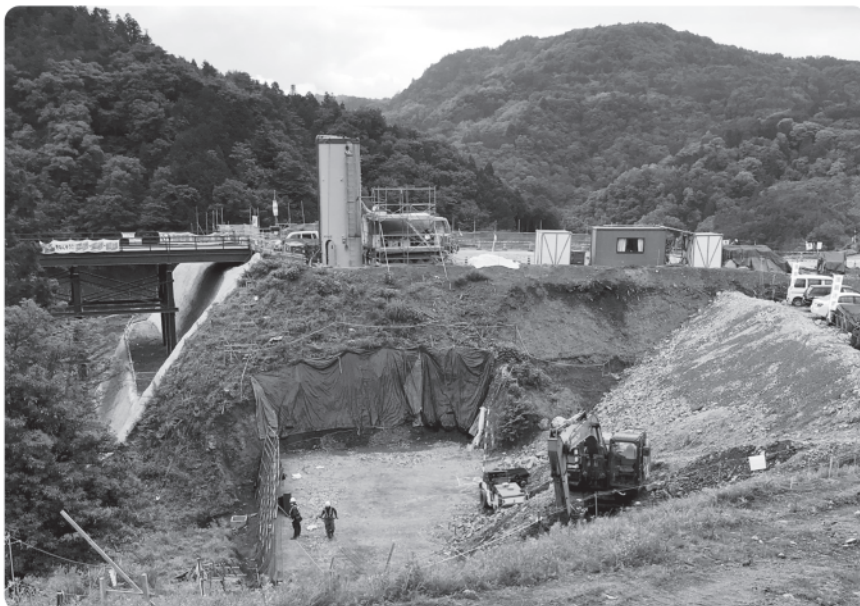
工事が進む保守基地・変電所用地（高下地区）
