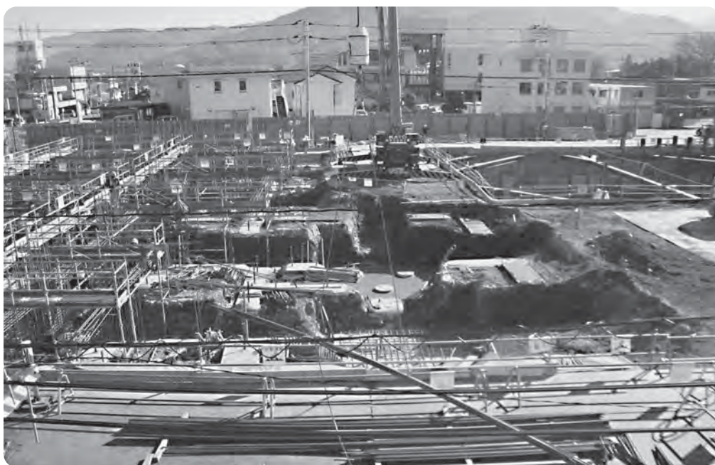
建設中の新庁舎
