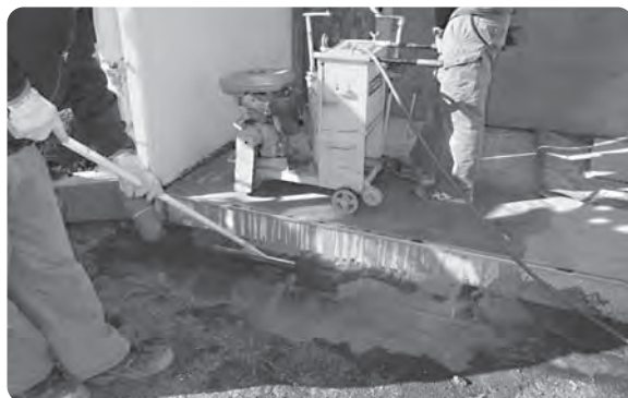
第2保育所給水管修繕工事の様子
