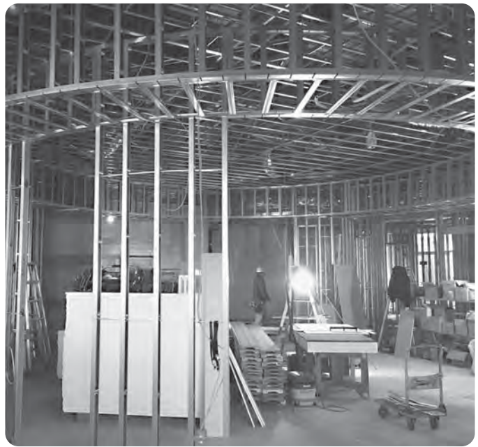
道の駅富士川に建設中の加工販売施設
