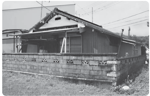
解体される長澤新町団地
