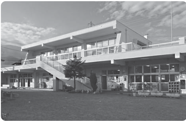
解体される旧第3保育所
