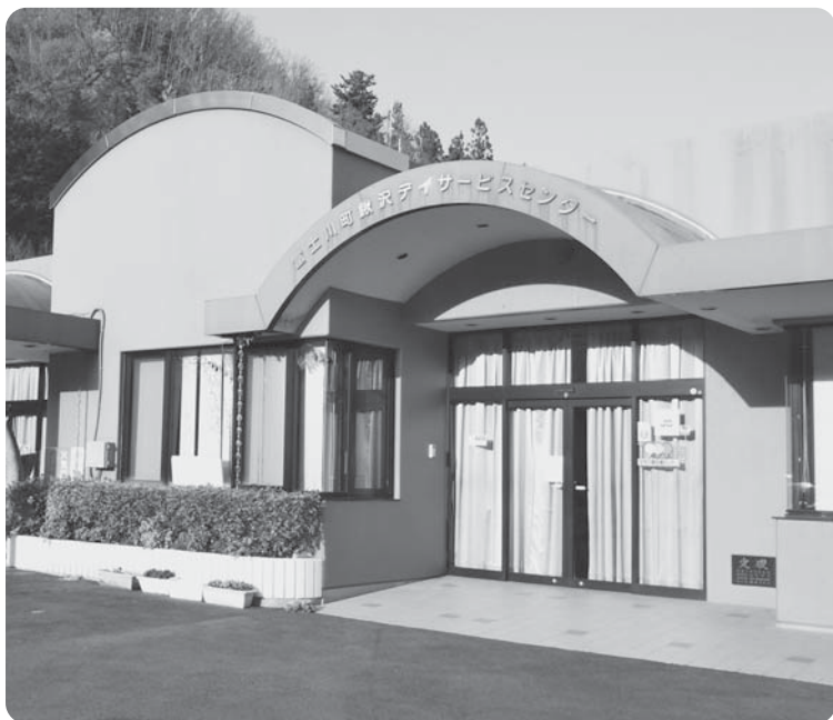
閉鎖となった鯉沢デイサービスセンター
