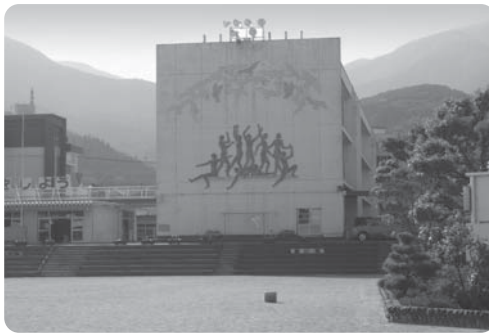
外壁塗装工事が行われる増穂小学校
