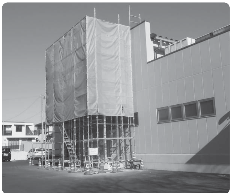
防音壁設置が進む学校給食センター
