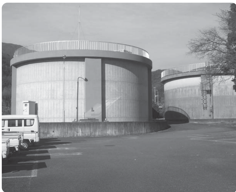
配水池 2000t 2基 (上下水道課敷地内)
