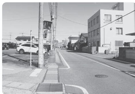
歩道改修予定の金手小林線
