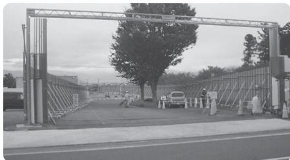
リニア工事現場
