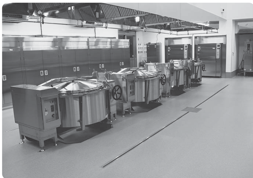
完成した給食センター内部
