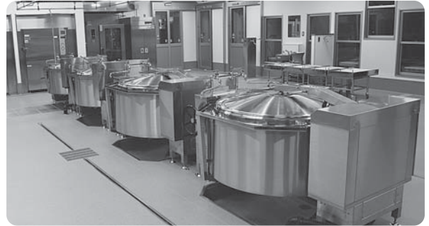
学校給食センター調理室
