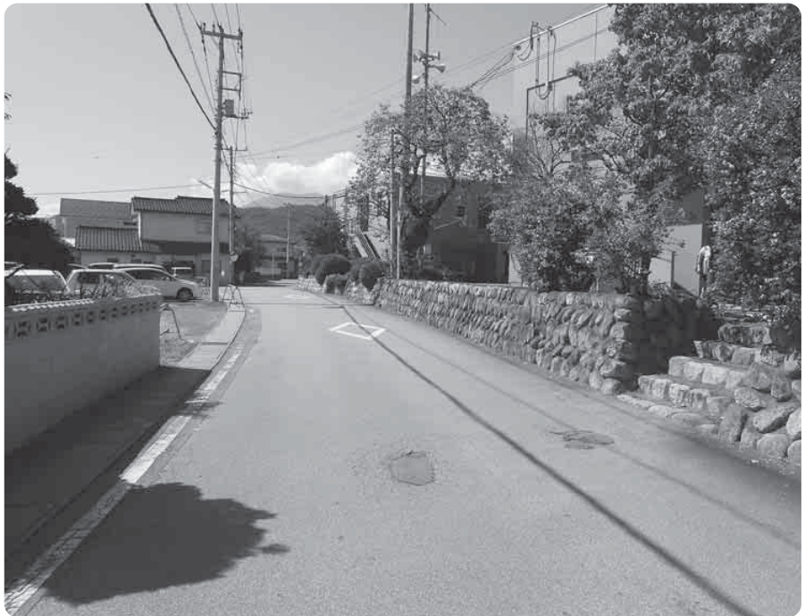
役場東側道路(最勝寺9号線)、1日1000人以上の住民が利用している
