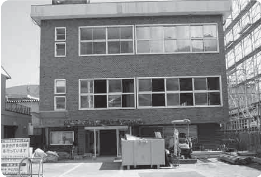
解体が進む鰻沢分庁舎
