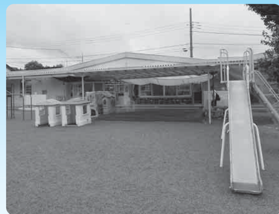
統合改修工事が始まる第4保育所
