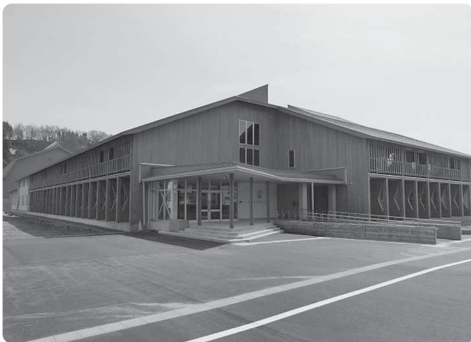
地域材の分離発注により建設された山形県鶴岡市朝日中学校
