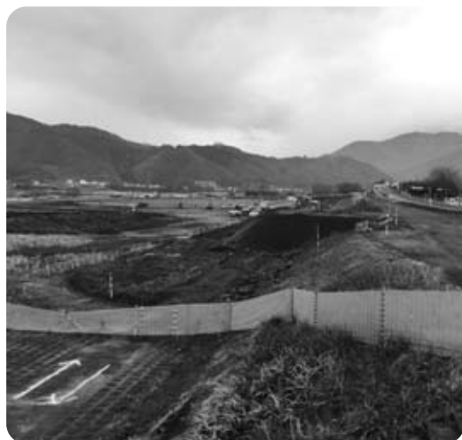
建設中の町民交流広場（富士川病院東側）
