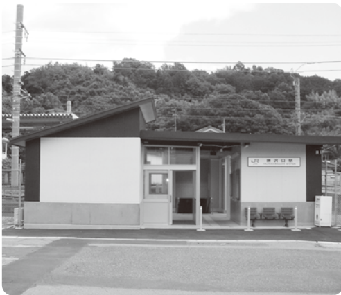
トイレが新設される鰻沢口駅
