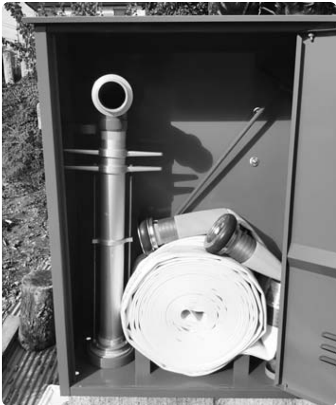
新しく設置されたスタンドパイプ
