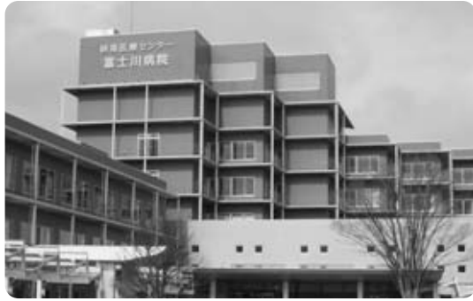
峡南医療センター富士川病院
