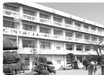
建具が耐震化される増中
