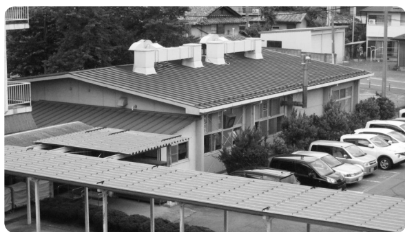
安全な水を供給（増小給食室）
