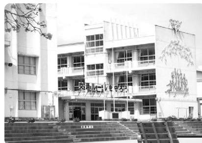
窓ガラス飛散防止が施工される増小
