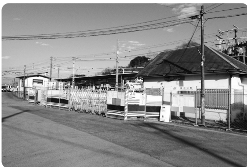
改修中の鵜沢口駅舎
