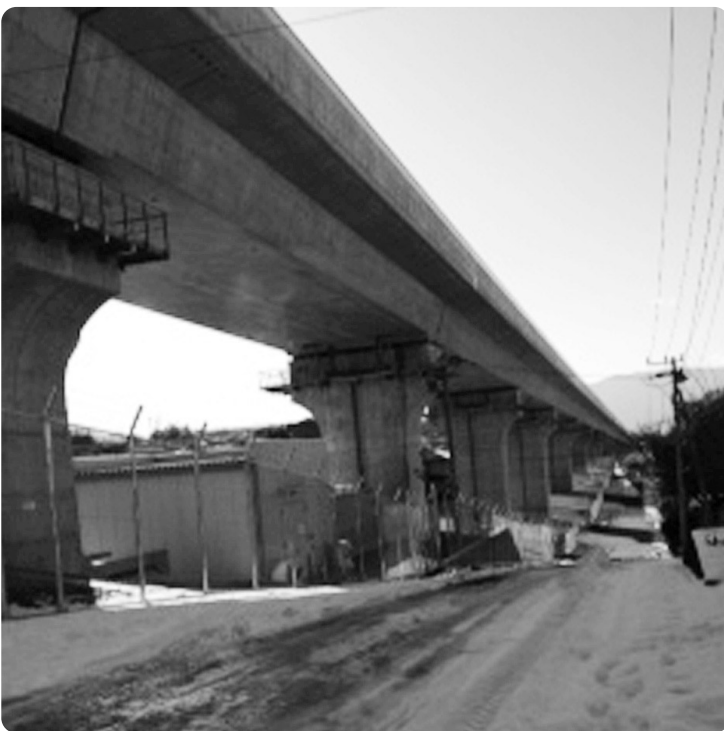
奪われる日照権(リニア実験線・笛吹市内)
