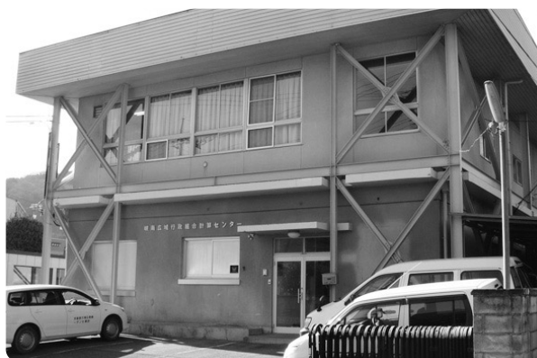
峡南広域行政組計算センター
