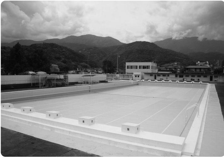
新町民会館の駐車場になる鯉沢プール
