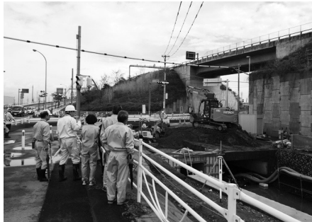
東川拡幅工事の現場
