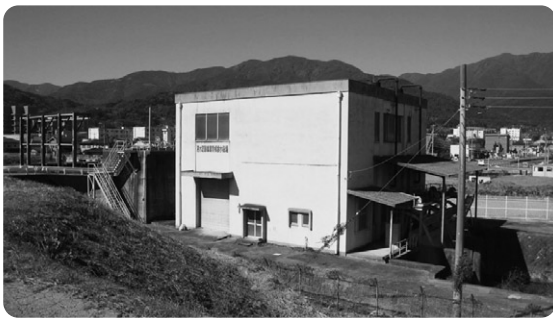
青柳排水機場
