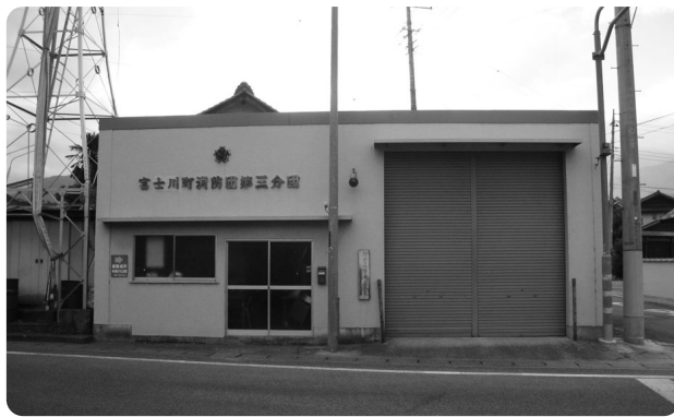
老朽化により移転が予定されている第3分団詰所（長澤地内）
