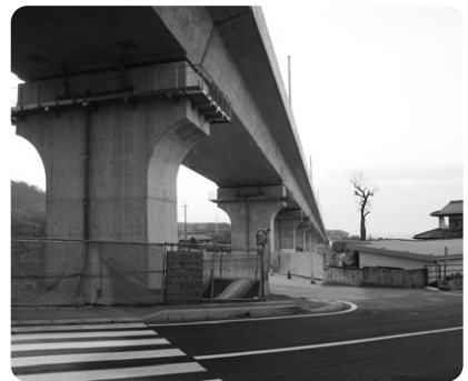
リニア高架橋
