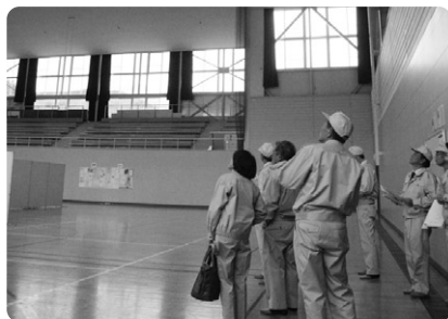
改修が急がれる鯉沢中学校体育館
