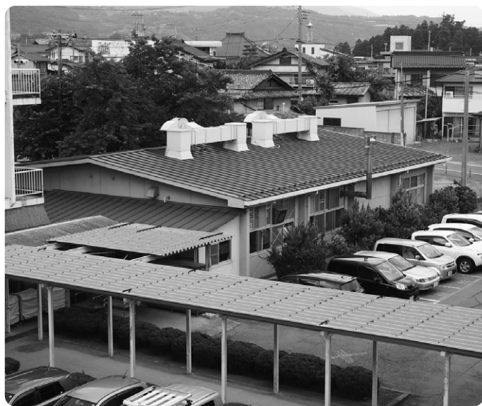
耐震化予定の増穂小学校給食室
