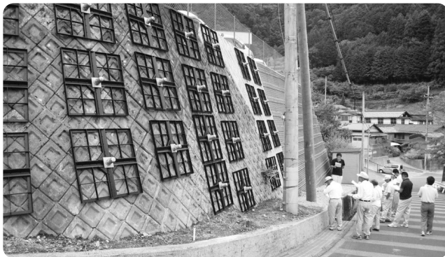
擁壁補強された十谷観光駐車場
