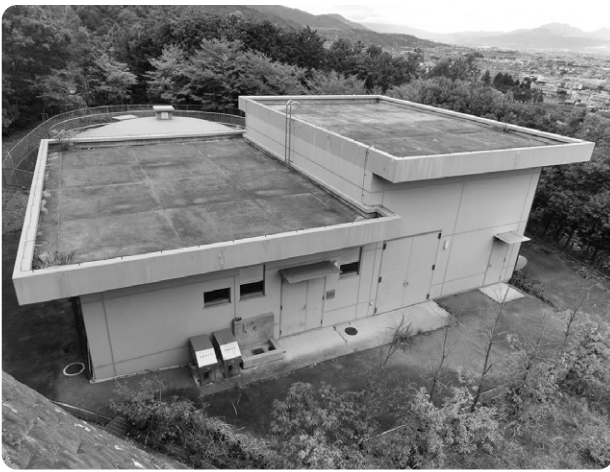
鯉沢本町地区簡水 大法師浄水場
