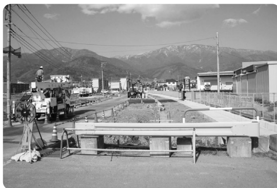
青柳11号線道路改良工事 (フォレストモール富士川南側)
