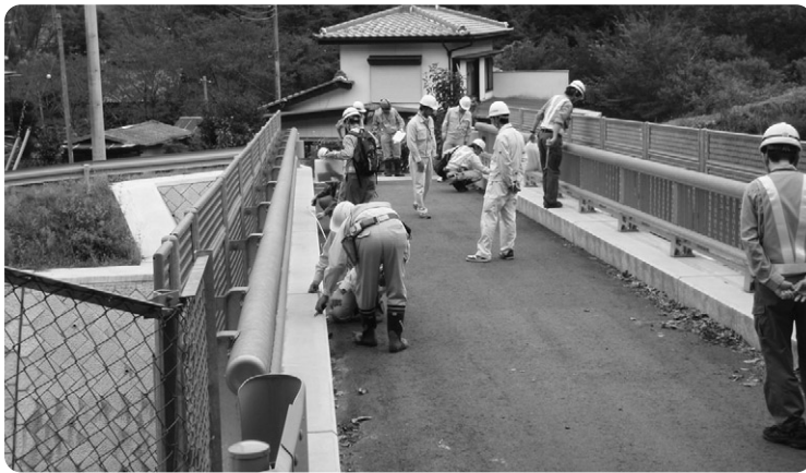
橋梁長寿命化の点検調査
