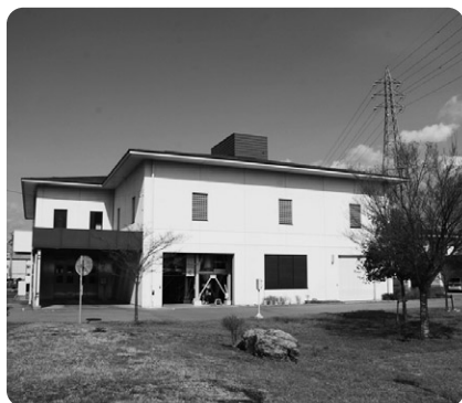
三郡衛生し尿処理場
