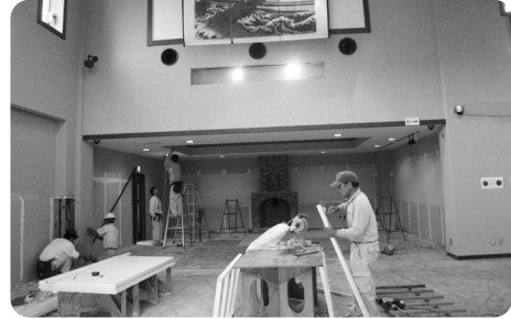
地域活性化施設塩の華の改修
