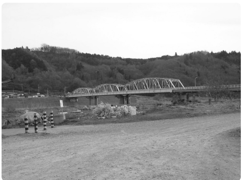
老朽化した富士橋
