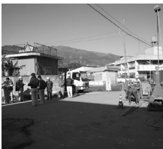
鯉沢汚水幹線33-24-4号管布設工事
