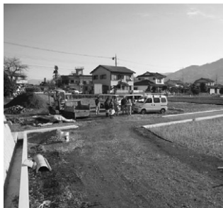
畔沢農作業道整備工事
