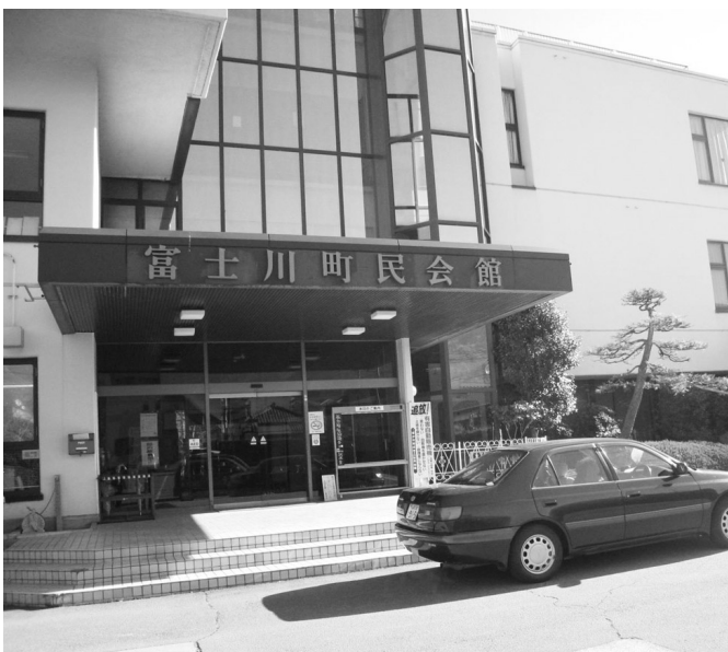
耐震化されていない町民会館
