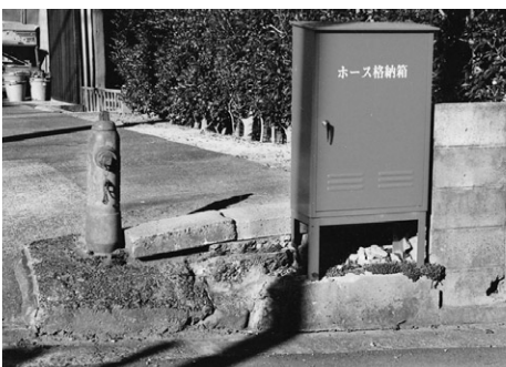
地上式消火栓
