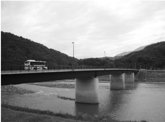
点検が実施された鹿島橋(鹿島地区)
