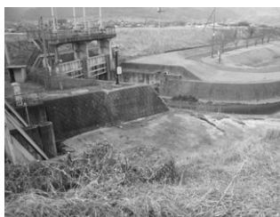
水門改修で浸水対策
