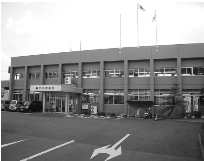
急がれる防災拠点本庁舎の耐震化！
