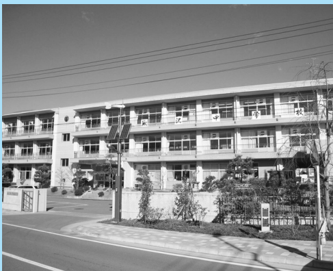
地下タンク埋設の鯉沢中
