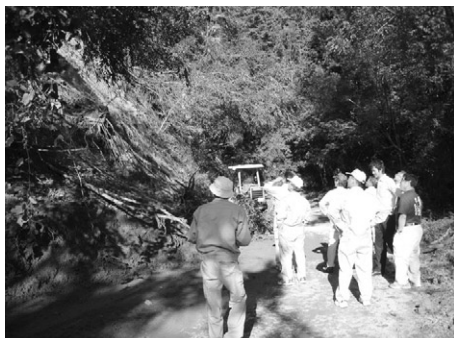
土砂崩落個所の視察
