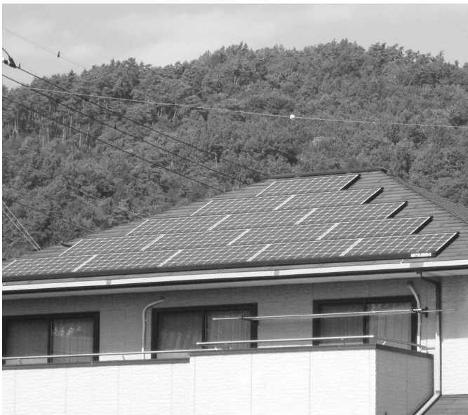
補助を利用した太陽光パネル
