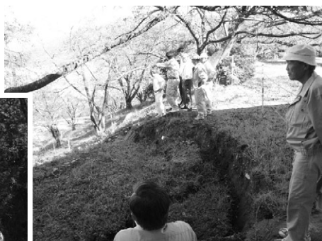
崩落した大法師公園
