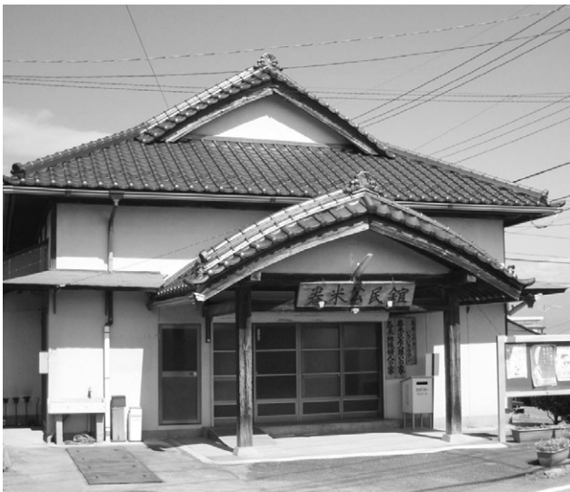
耐震化された菴米公民館
