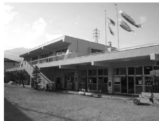
エアコンが設置される 各保育所
