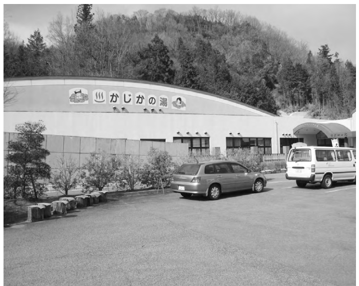
バイオマスボイラーの導入の可能性は（かじかの湯）
