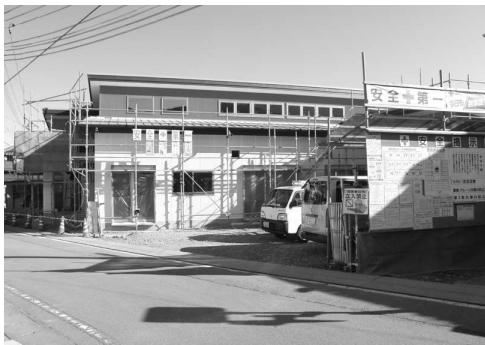
建設中の小林区公民館
