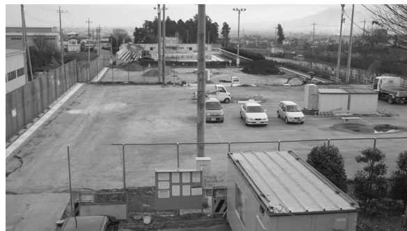
改修中のテニスコート
