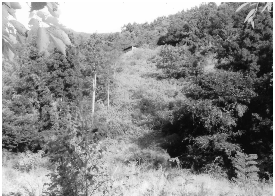
草、ツルで覆われた崩落現場
