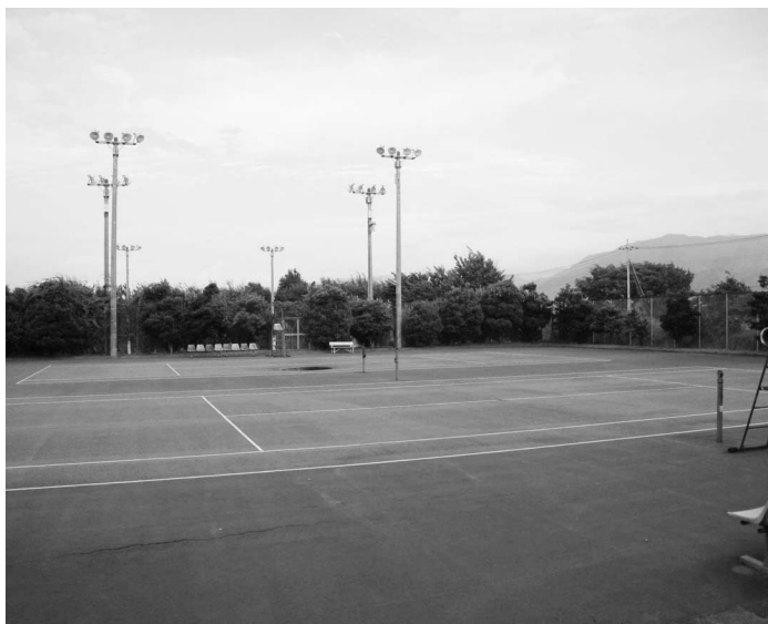
改修予定の利根川公園テニスコート
