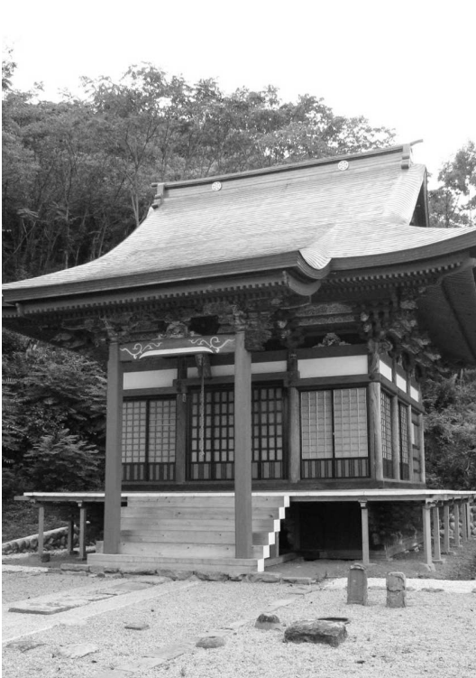
修繕された横向七面堂
