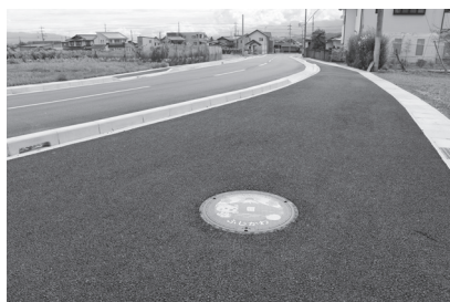
▲ はくばく文化ホール北側歩道内
