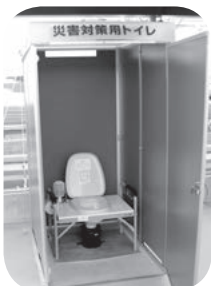
▲災害用として駐車場にマンホールトイレを備えています
