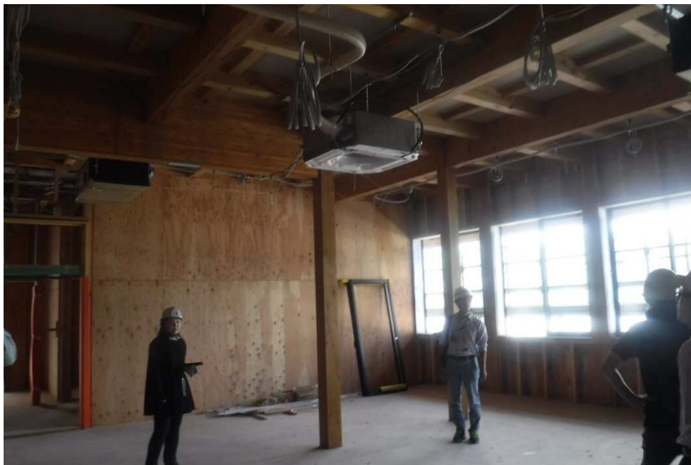
木造公共施設建設
