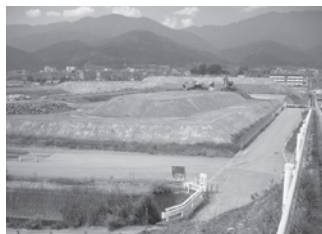
▲整備が進む道の駅周辺
