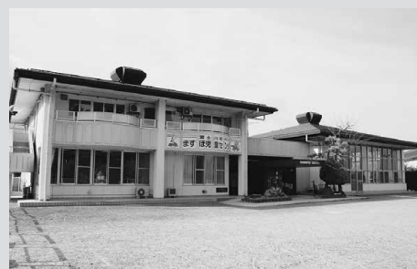
◀解体される ますほ児童セ ンター
