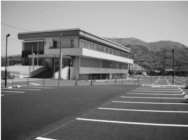
▲公共施設再配置計画の第一弾として整備した 新町民会館と駐車場
