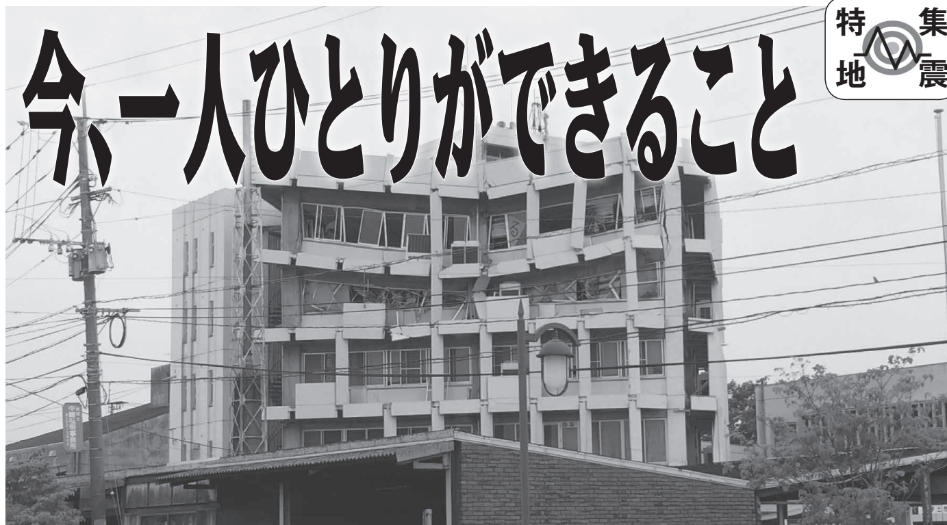
▲半壊した熊本県宇土市役所本庁舎（5月6日撮影）
