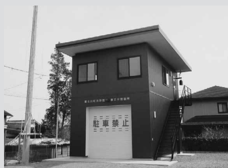
◀ 防火水槽を設置する第3分団詰所
