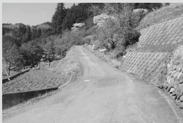
◀ 農道が新設される小室地区
