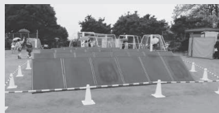
▲会場に設置した太陽光パネル
