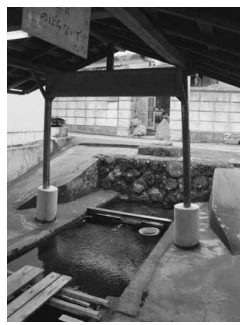
諏沢中区にある上北の共同水場
