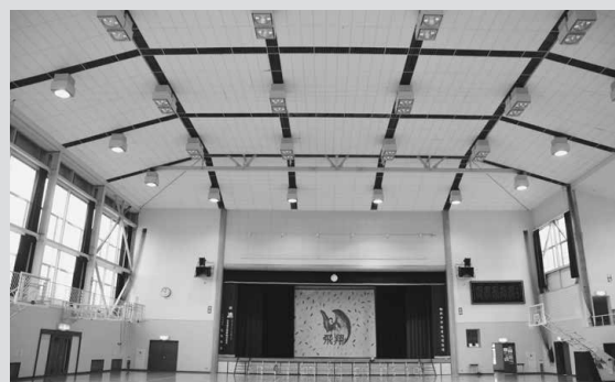
▲天井改修が行われる鯉沢中学校屋内運動場
